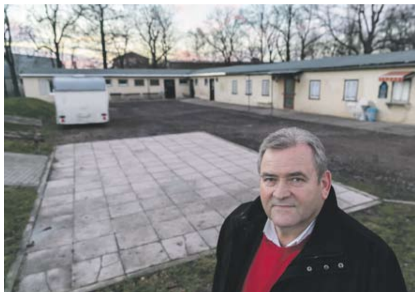
Dringend saniierungsbedürftig, der Schimmel kriecht die Wände hoch, private Sponsoren stehen bereit, aber die Stadt zieht nicht mit: Georg Bräutigam vor den Umkleidekabinen am Sportplatz Obertunk
